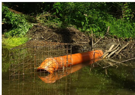
Drénování bobří hráze je vložení roury do hráze, které má za cíl snížení úrovně hladiny v bobří zdrži na úroveň akceptovatelnou jak pro tyto hlodavce, tak pro ostatní uživatele krajiny. / As part of the beaver dam drainage, we inserted a pipe into the dam to lower the level to one acceptable to both rodents and other terrestrial users.
