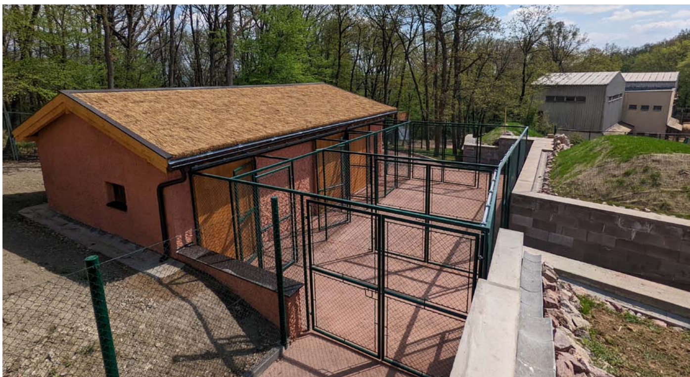
Nové zázemí pro pštrosy, v pozadí stáje pro žirafy. / The new ostrich facility, with the giraffe stables in the background.
