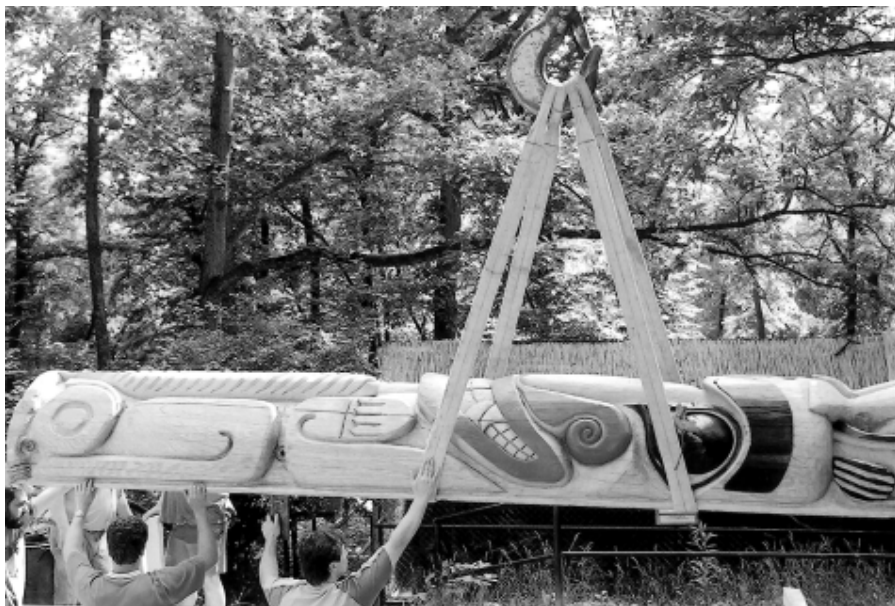
Montáž totemu / Construction of the totem Foto: Eduard Stuchlík
