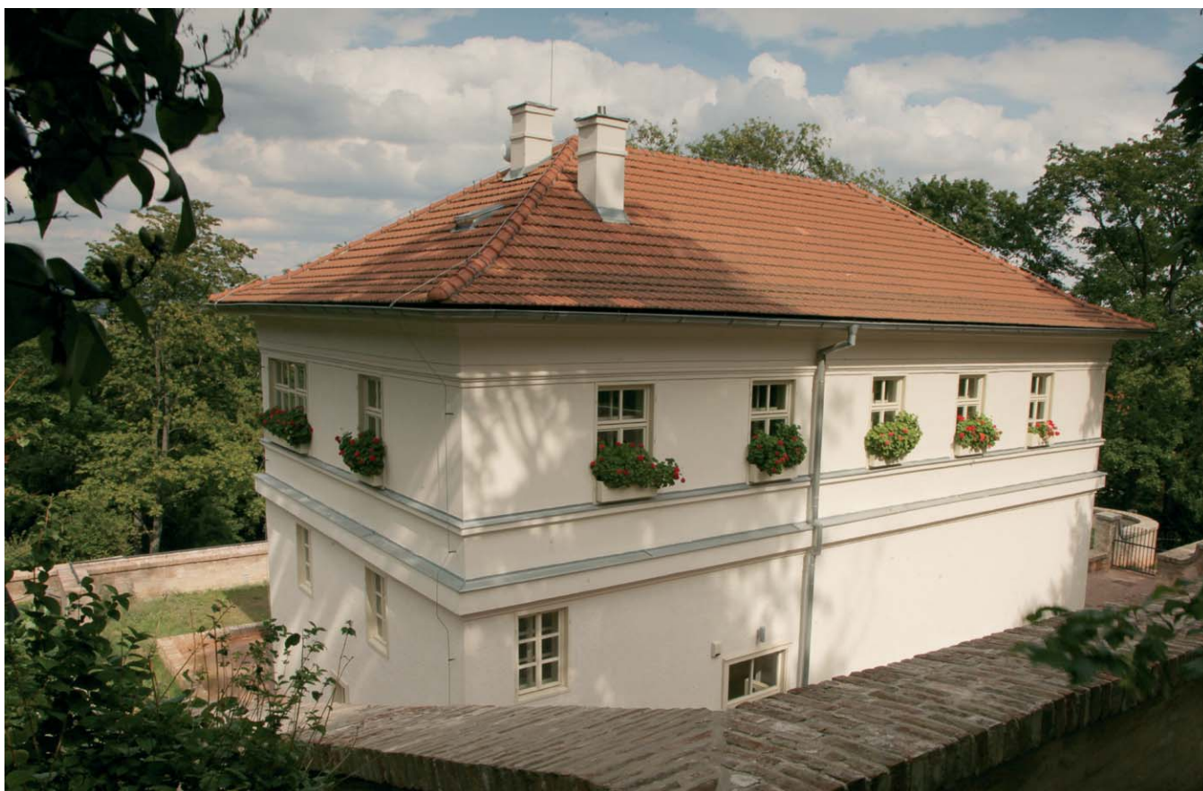
Ekostředisko sídlí v památkově chráněné, rekonstruované budově Hlídka 4, stojící v centru města, v parku pod hradem Špilberkem/This previously dilapidated building at Hlídka 4 has become a source of civic pride thanks to an enlightened investor (the City of Brno) and conservationists. Now there resides Environmental Centre
