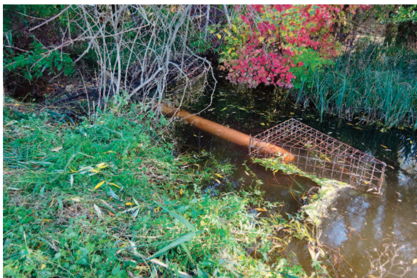
Drénování bobří hráze u obce Hrabětice. Autor: Jitka Uhlíková
