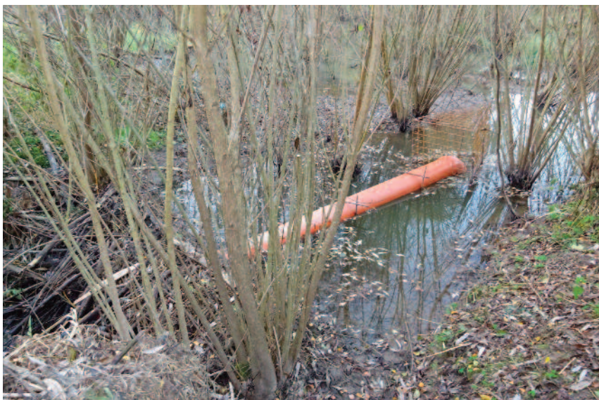
Drénování bobří hráze v Havlíčkově Brodě. Autor: Jitka Uhlíková
