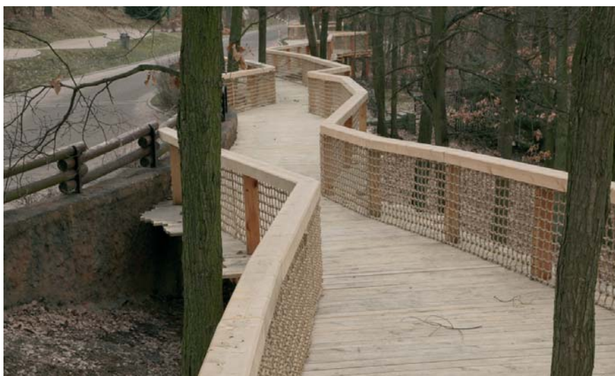
Dřevěná lávka zbudovaná v místě budoucího výběhu klokanů umožní průchod návštěvníků během stavby a po jejím dokončení zajistí bezpečný provoz po hlavní komunikaci / The wooden bridge built in the site of the future will run kangaroos passage of visitors during construction and after completion to ensure safe operation of the main road
