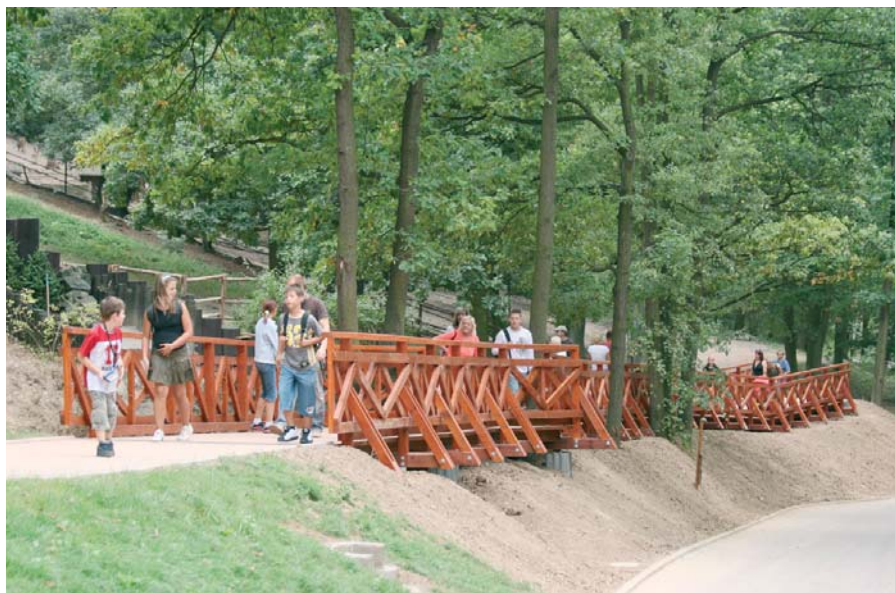
Lávka na páteřní komunikaci / Footbridge on backbone foot-path
